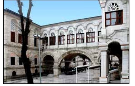
Hünkâr köşkünden, hünkâr mahfiline geçiş köprüsü.
